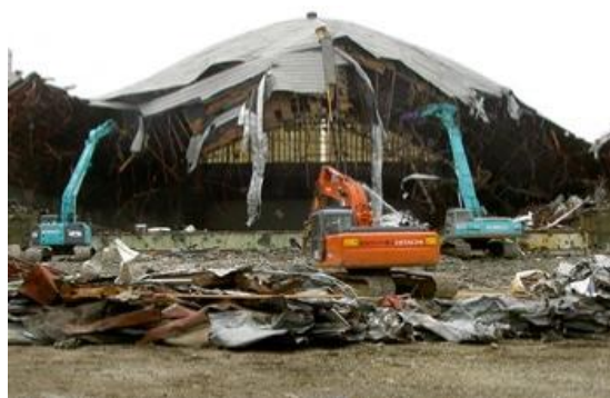
2009年1月31日に閉鎖・用途停止した 旧長岡市厚生会館 の解体工事の様子
