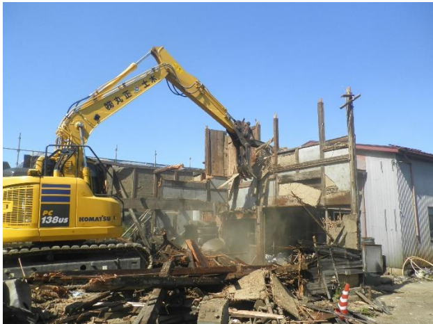
木造建物解体工事
