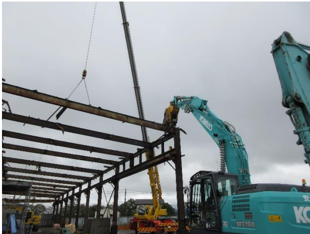
鉄骨造建物解体工事
