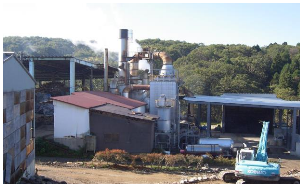
焼却処理プラント
