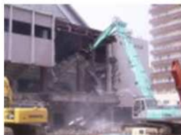
長岡市厚生会館 解体工事
