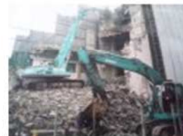
柏崎市 コンタ様 解体工事
