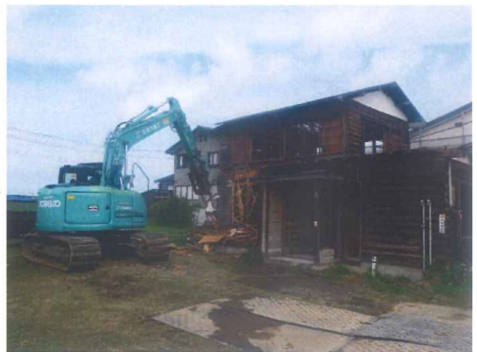
某住宅木造解体
