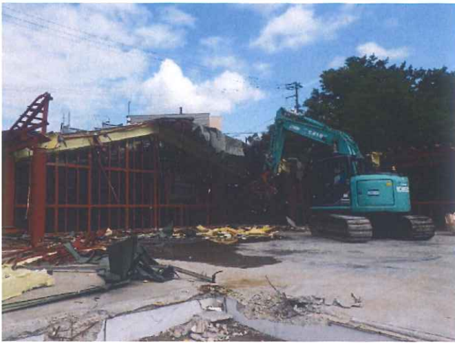
某庁舎鉄骨解体
