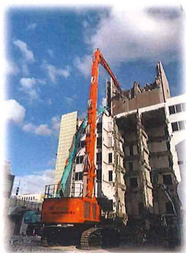
▲長岡商工会議所 解体工事
