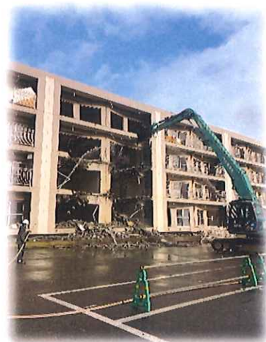
▲新潟市西区寺尾アパート 解体工事
