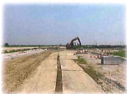
▲長岡北スマート IC 工業団地 造道工事
