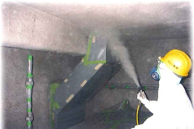
石綿飛散防止材散布
